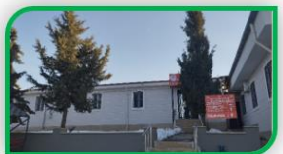
Resim 4: Polateli İlçesi Ek Hizmet Binası
